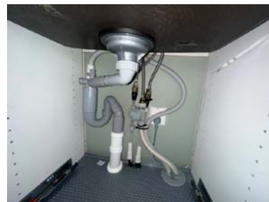
Røropplegg i kjøkkenbenk med Waterguard
