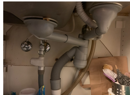
Røropplegget i kjøkken
