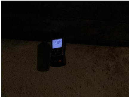
Fuktmåling i treverk i himling.
