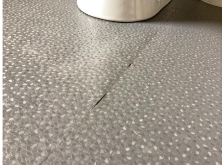
Banemembran løsner noen steder fra underlag.
