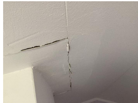
Gjenstår ferdigstilling rundt pipe.
