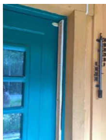
Det er montert ekstra list på utsiden av dør.
