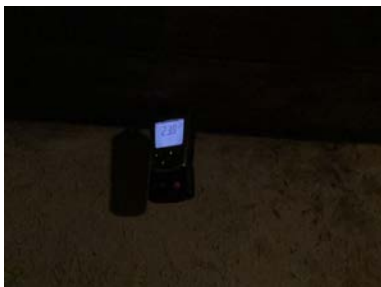
Fuktmåling i treverk i himling.
