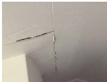
Gjenstår ferdigstilling rundt pipe.
