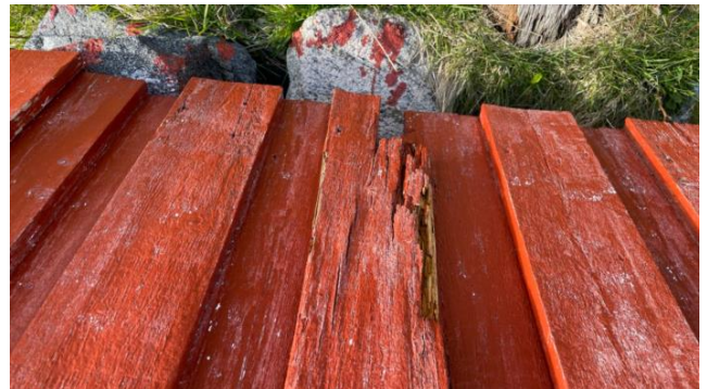
Fuktskader i yttervegg.
