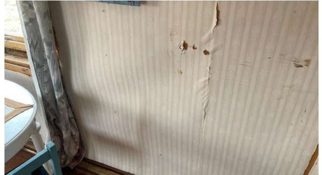
Fuktskader i yttervegg.
