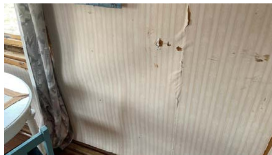
Fuktskader i yttervegg.
