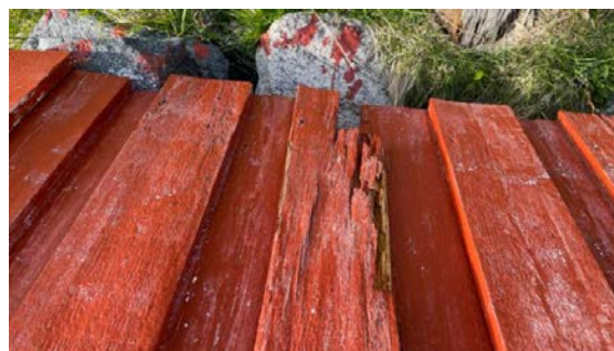
Fuktskader i yttervegg.
