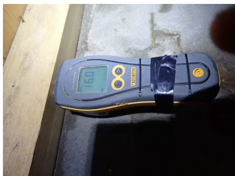
Fuktmåling i treverk ved synlig fukt i bod 3.
