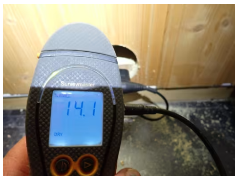
Fuktmåling i utforet vegg på kontor/kjellerstue.
