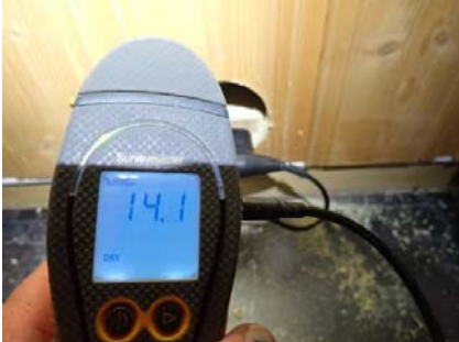
Fuktmåling i utforet vegg på kontor/kjellerstue.
