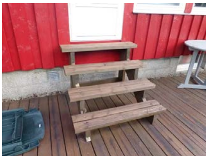
Trapp til terrassedør.
