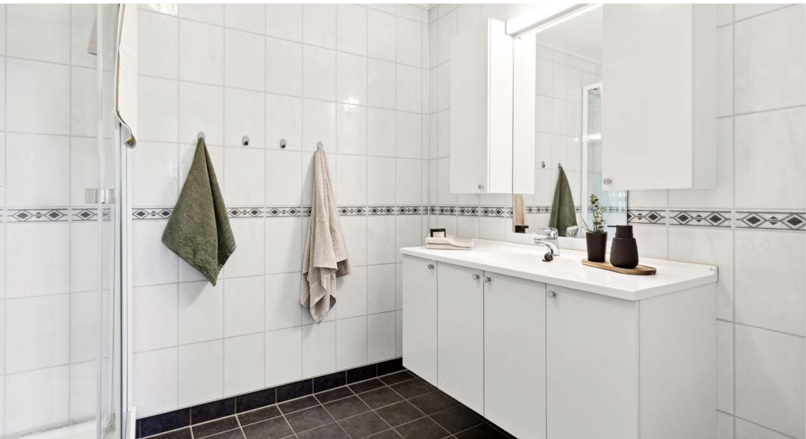
Begge bad har flislagt gulv og flisimiterte plater på veggene.
