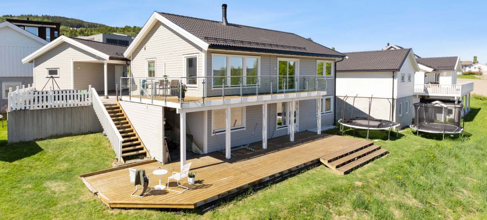
Aktiv Eiendomsmegling v/ Marius Kvalvik har gleden av å presentere Hammergjerdet 4 – en svært tiltalende enebolig med sjønær og barnevennlig beliggenhet.
