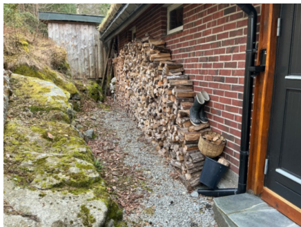
Vegg i teglstein fra opprinnelig byggeår 1970 tallet.
