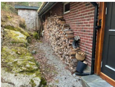
Vegg i teglstein fra opprinnelig byggeår 1970 tallet.
