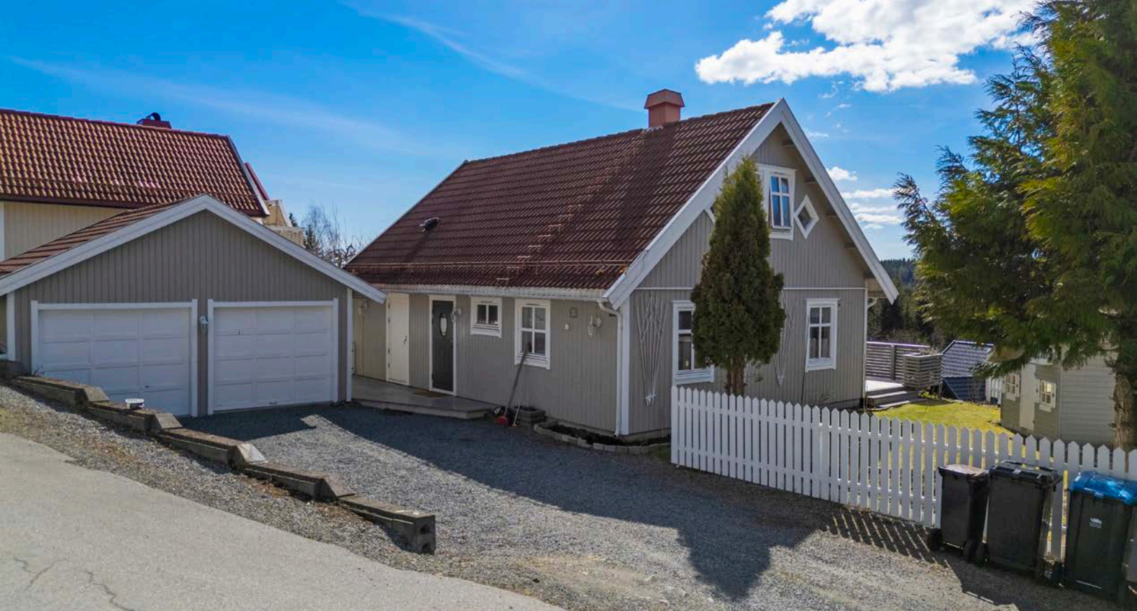
Dobbelgarasje på eiendommen.
