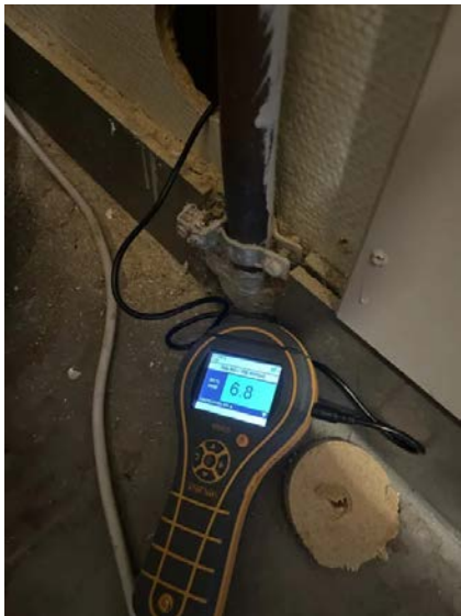
Ingen indikasjon på fukt i vegg bak våtsone
