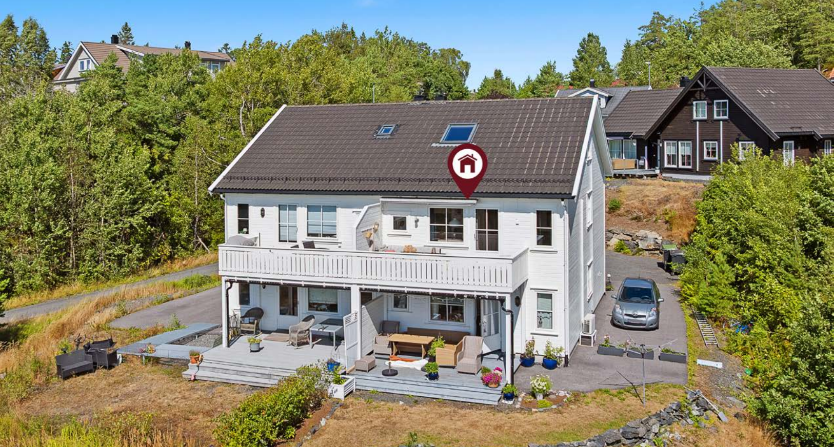
Pen og innbydende leilighet beliggende i 2. etasje i 4-mannsbolig oppført i 2006.
