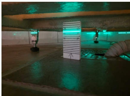
Laser plassert ved døren, ca. 20mm høydeforskjell
