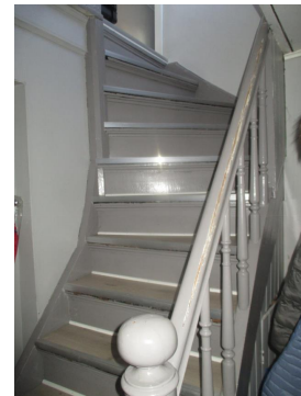
Trapp i mellom første og andre etasje.
