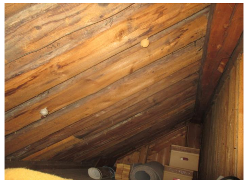
Deler av takkonstruksjonen på ene knekott.
