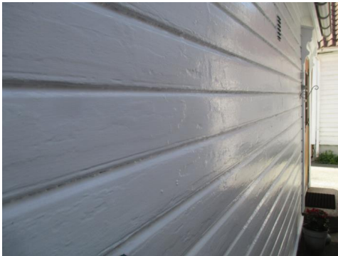
Deler av fasade med eldre kledning.
