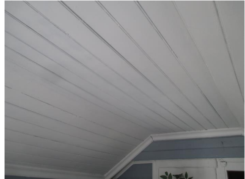
Det meste av takkonstruksjonen er en lukket konstruksjon.
