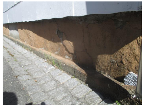
Grunnmur i mot gate.
