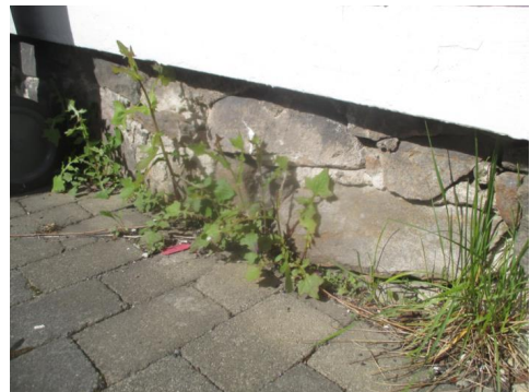
Deler av grunnmur utvendig.
