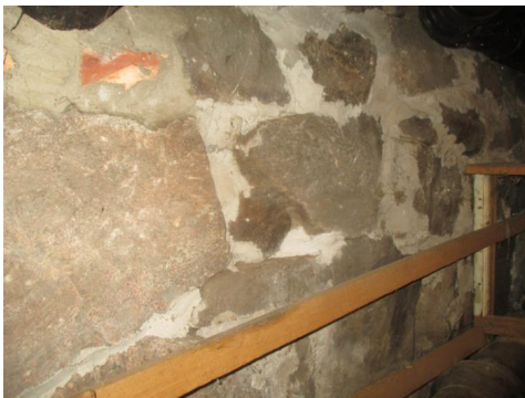
Deler av tykk grunnmur.
