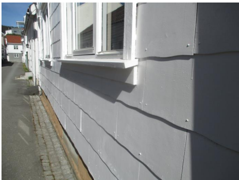
Fasade i mot gate med tilhørende belistninger.
