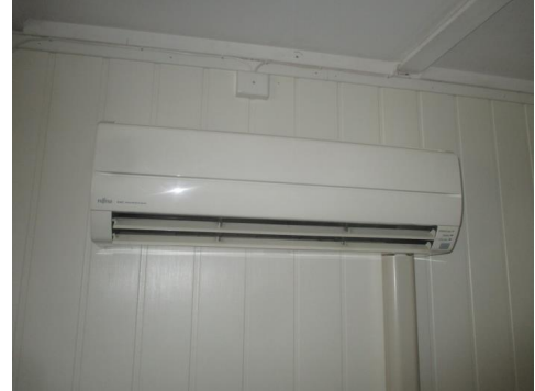
Varmepumpe er blitt installert.
