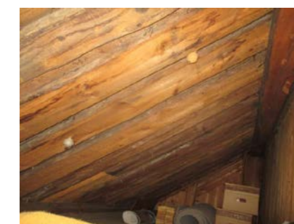
Deler av takkonstruksjonen på ene knekott.
