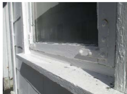
Eldre slitt vindu i første etasje.
