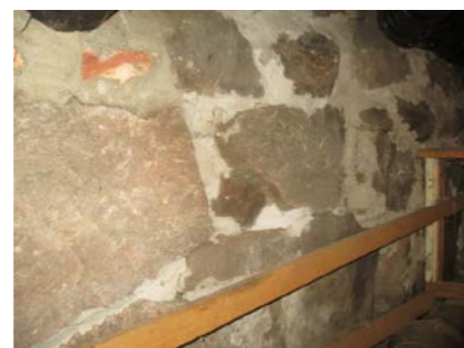
Tykk grunnmur av steinblokker.
