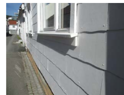
Fasade i mot gate med tilhørende belistninger.
