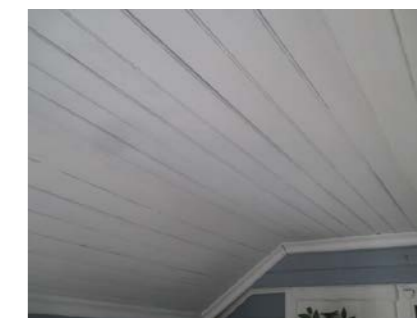
Det meste av takkonstruksjonen er en lukket konstruksjon.
