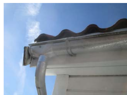
Deler av takrenner.
