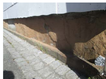
Grunnmur i mot gate.
