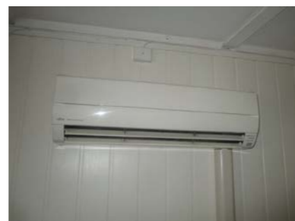
Varmepumpe er blitt installert.
