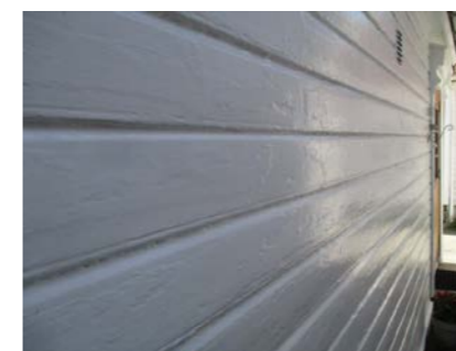
Deler av fasade med eldre kledning.
