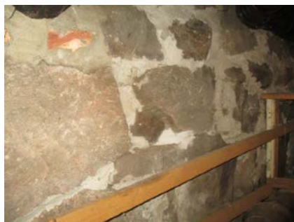
Deler av tykk grunnmur.
