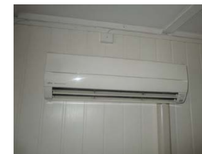
Varmepumpe er blitt installert.
