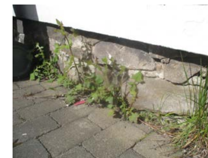
Deler av grunnmur utvendig.
