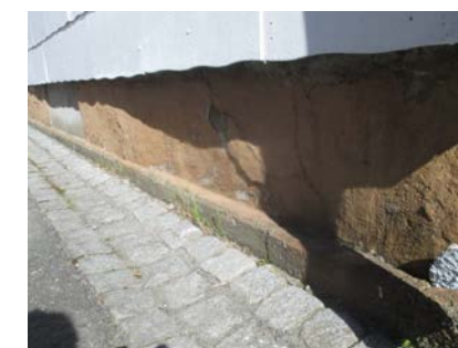
Grunnmur i mot gate.
