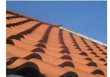
Taktekking av teglstein.
