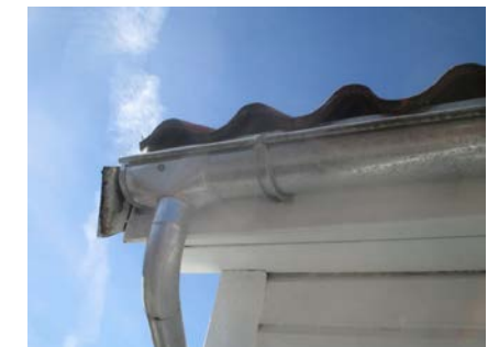
Deler av takrenner.
