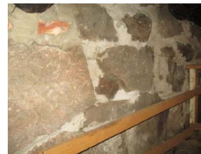
Deler av tykk grunnmur.
