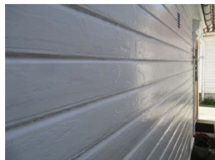
Deler av fasade med eldre kledning.
