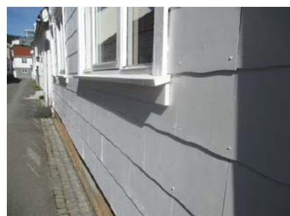
Fasade i mot gate med tilhørende belistninger.
