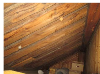
Deler av takkonstruksjonen på ene knekott.
