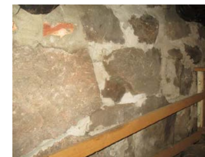
Tykk grunnmur av steinblokker.
