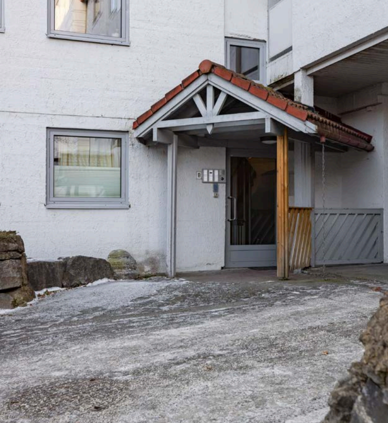
Overbygget inngangsparti i bakgården.
