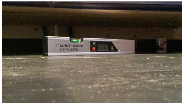
Viser motfall under baderomsinnredning
