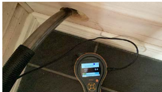
Viser utført fuktmåling uten å avdekke unormale verdier av fukt.
