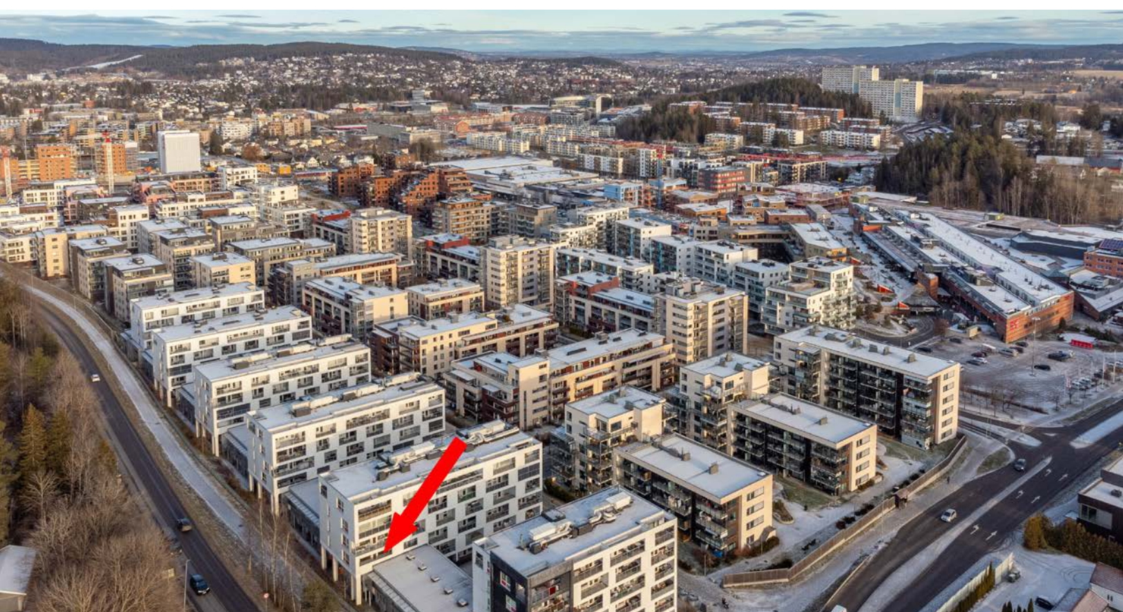
Leiligheten ligger i byggets tredje etasje og er markert med pil.
