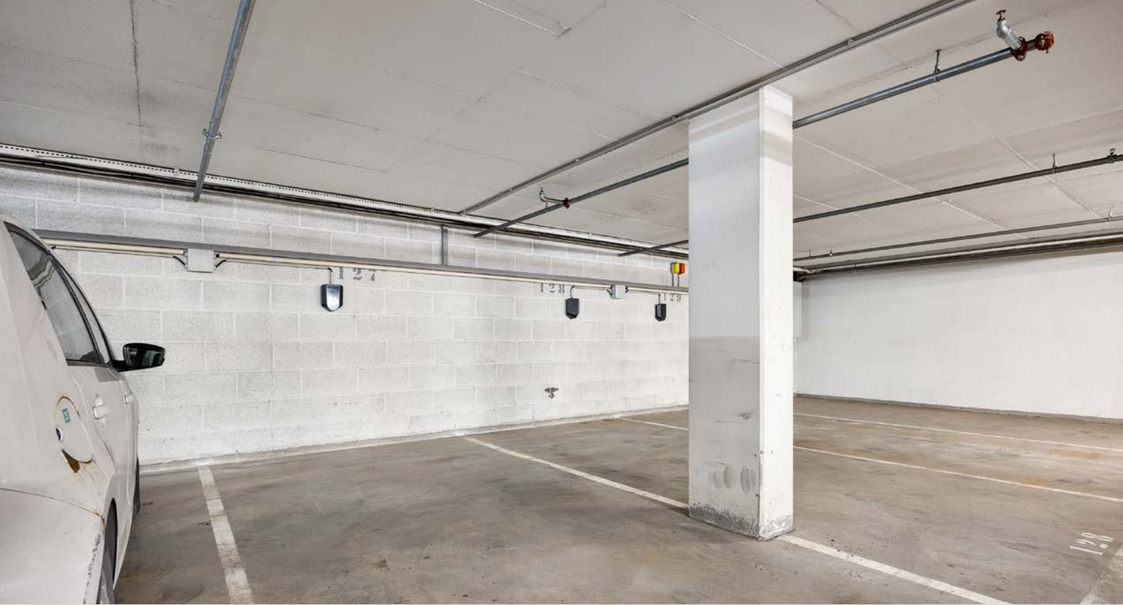
Leiligheten har plass nr 127. Tilrettelagt med infrastruktur for lader.
