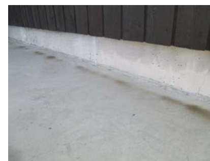
Deler av ringmur som er isolert utvendig.
