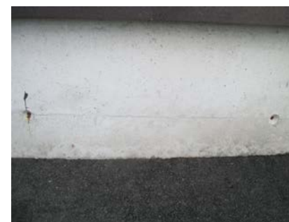
Støpt ringmur i rundt garasje.
