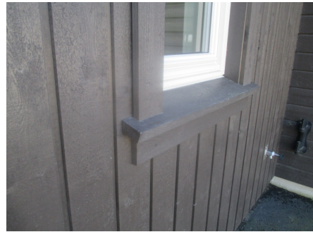
Deler av kledningen med tilhørende belistninger
