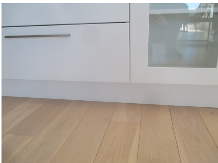
Hulltaking fra kjøkken.
