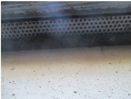
God lufting med musetetting i mot grunnmur
