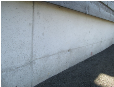
Støpt grunnmur som er tilbakefylt
