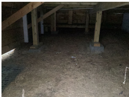
Fundamentering av veranda.
