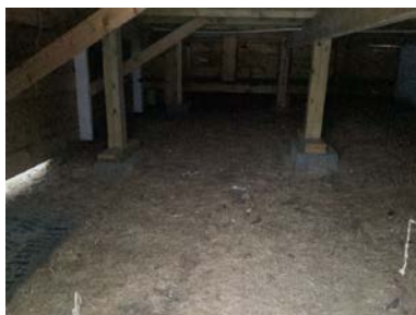
Fundamentering av veranda.
