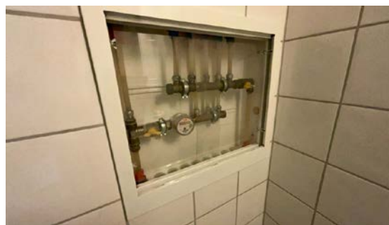
Besiktigelse av røropplegg.
