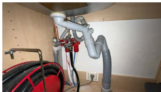
Besiktigelse av røropplegg.
