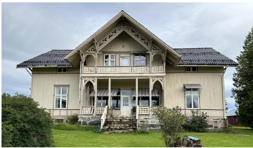
Hovedbygg fra hageside, syd.
