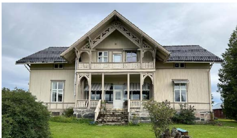
Hovedbygg fra hageside, syd.
