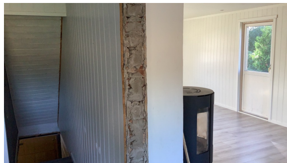
En side av pipen er igjenkledd.
