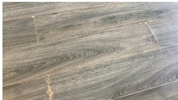
Eksempel på skadet gulv.
