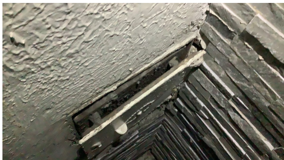
Kappede hengsler på sotluke.
