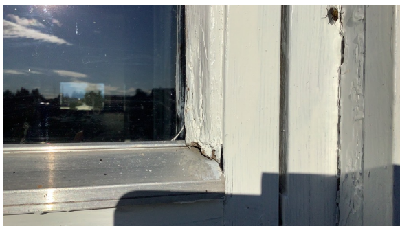
Råteskadet glasslist.
