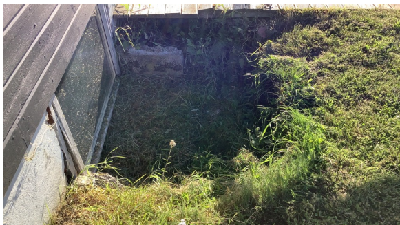
Utgraving foran stort kjellervindu.
