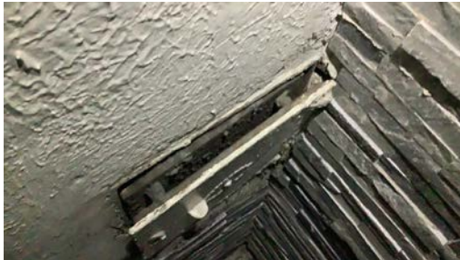
Kappede hengsler på sotluge.
