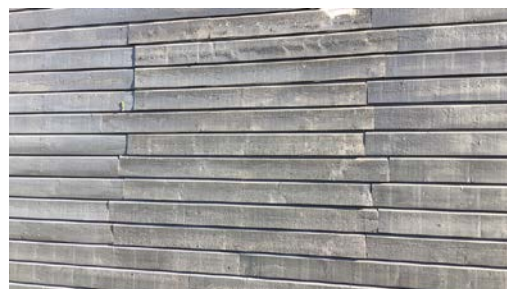
Tidligere vindusåpning er enkelt igjenkledd.
