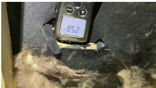
Det måles skadelig fuktinnhold i påføring på grunnmur.
