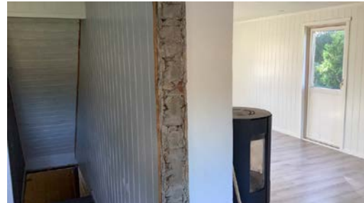
En side av pipen er igjenkledd.
