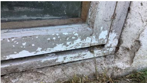
Værslitt kjellervindu.
