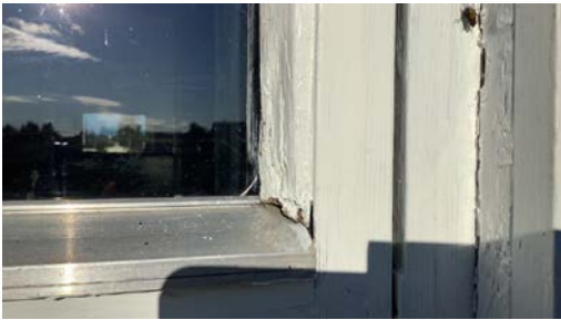
Råteskadet glasslist.
