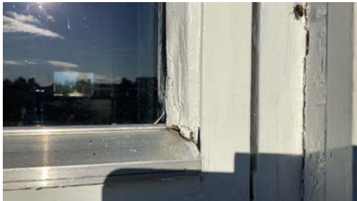
Råteskadet glasslist.
