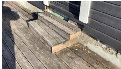
Trapp til balkongdør har enkel utførelse.
