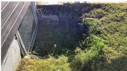
Utgraving foran stort kjellervindu.
