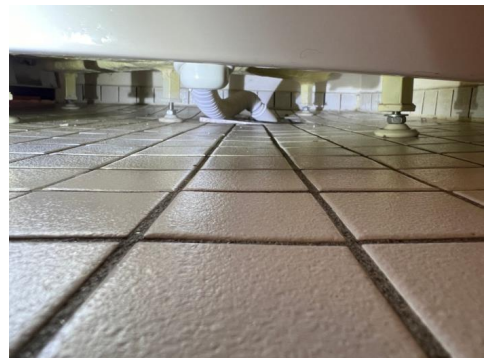
Bildet viser avløp ført ned i sluk fra kabinett.
