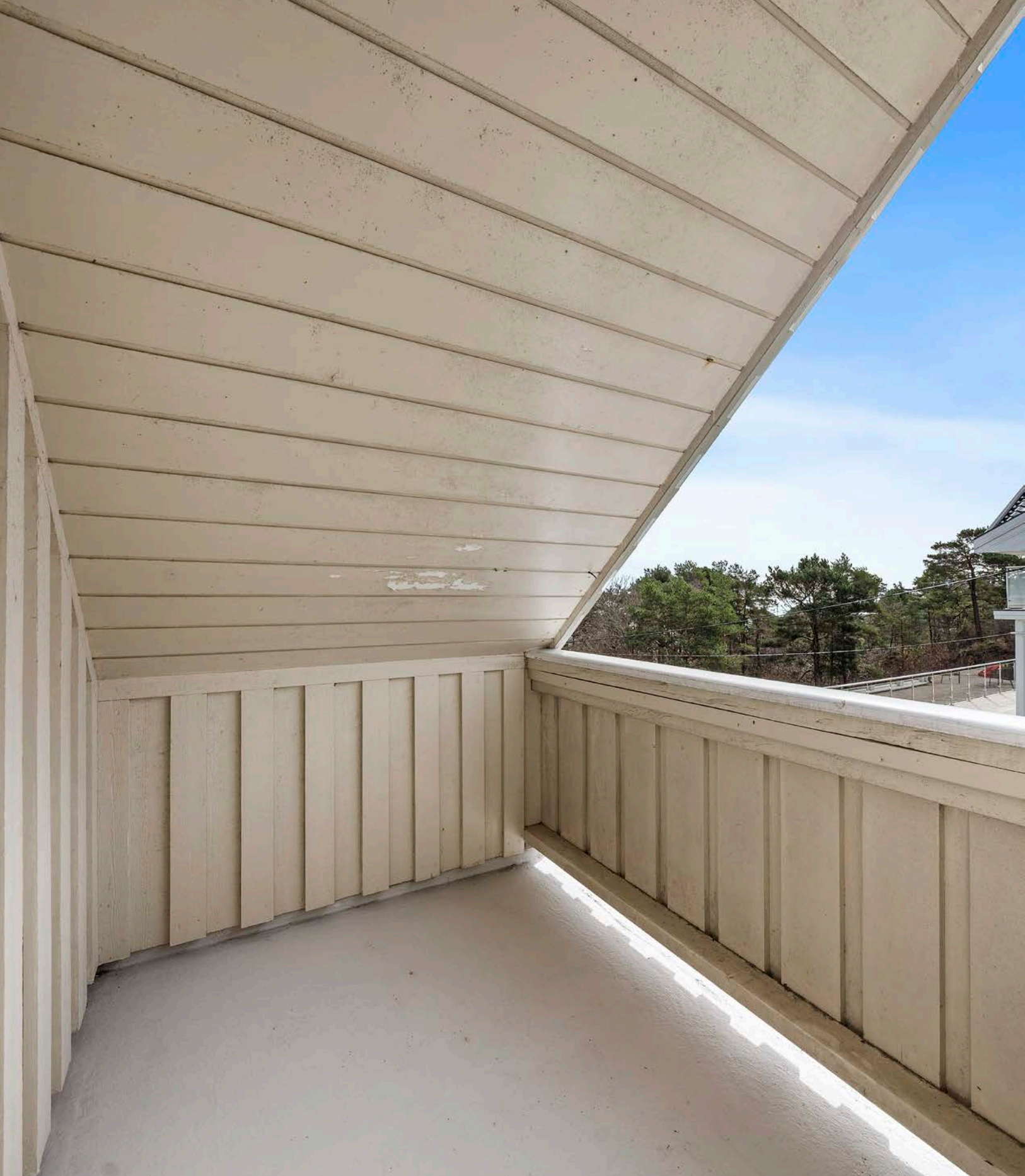
Luftebalkong med utg. fra soverom
