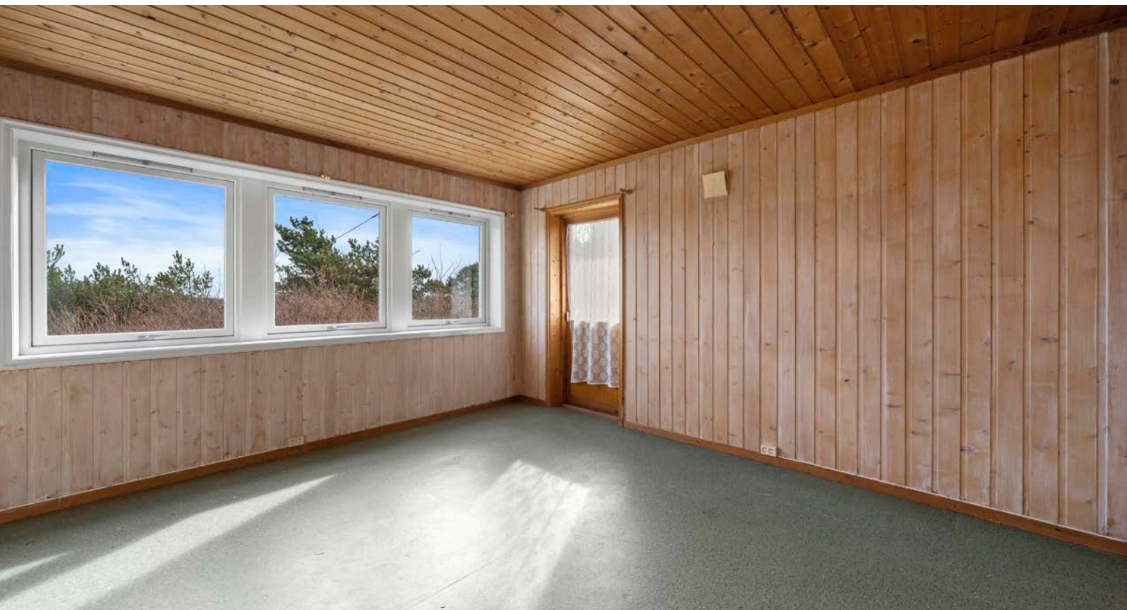
Det første rommet har store vinduer og verandadør ut til hage mot sør, mens det innerste rommet har mindre vindu og oppfyller ikke krav til varig opphold.
