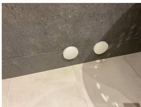
Drenering fra fordelerskap (se punkt for vannrør)
