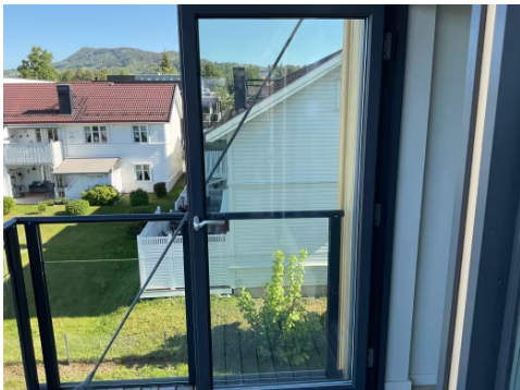
Bygningen har 3-lags glass fra 2022.
