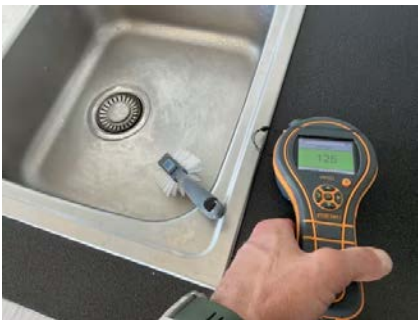
Ingen indkasjon på fuktighet
