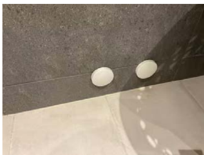
Drenering fra fordelingsskap
