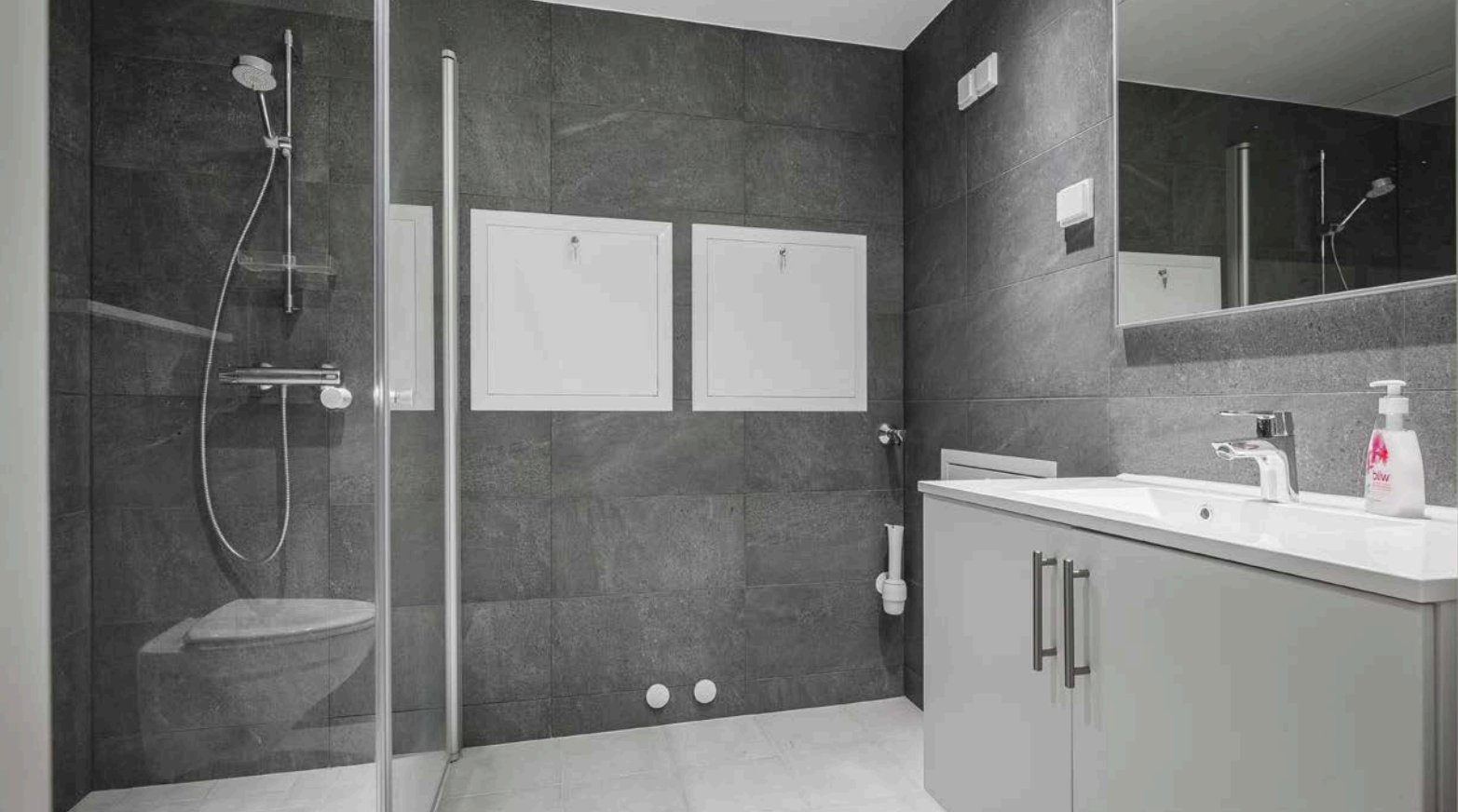
Moderne flislagt baderom fra byggeåret 2023. I hjørnet er det plass og opplegg for vaskemaskin, og tørketrommel over om ønskelig.
