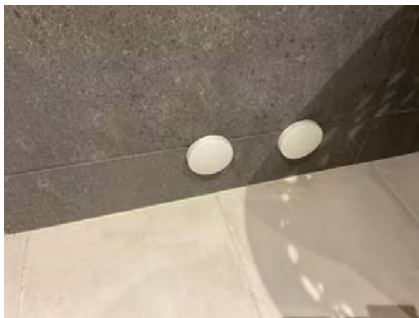
Drenering fra fordelerskap (se punkt for vannrør)
