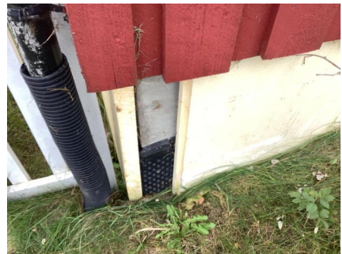
Bildene viser at det er synlig fuktsperre bak isolasjon.
