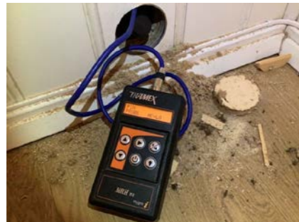
Bildet viser hulltaking og at det måles tørt.
