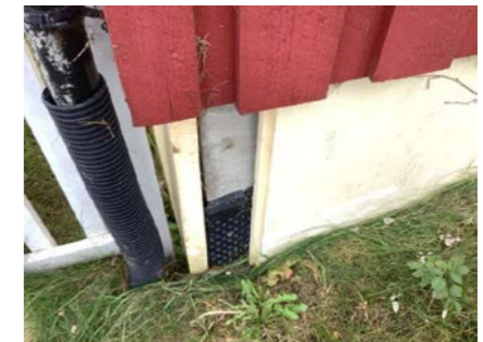
Bildene viser at det er synlig fuktsperre bak isolasjon.
