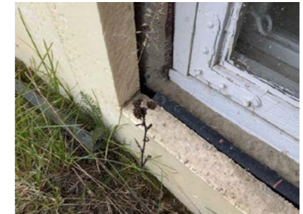
Bildene viser at det er synlig fuktsperre bak isolasjon.
