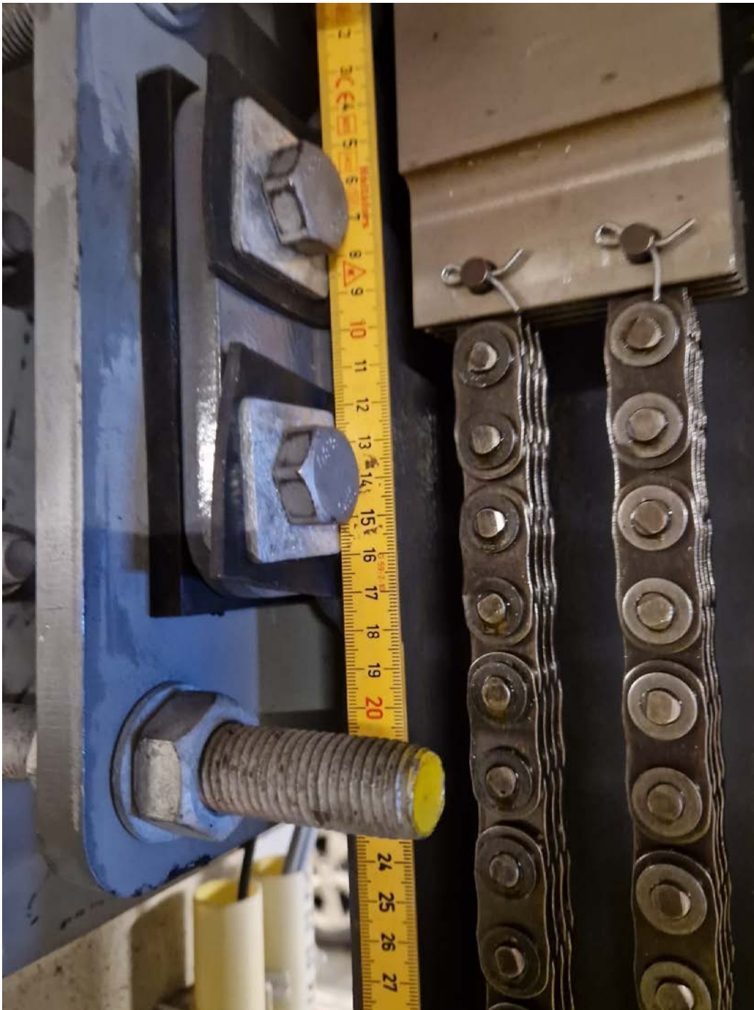
Foto 69: Innfesting mot søyle
