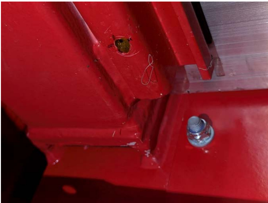
Foto 34: Hull for drenering over renne i plattformen
