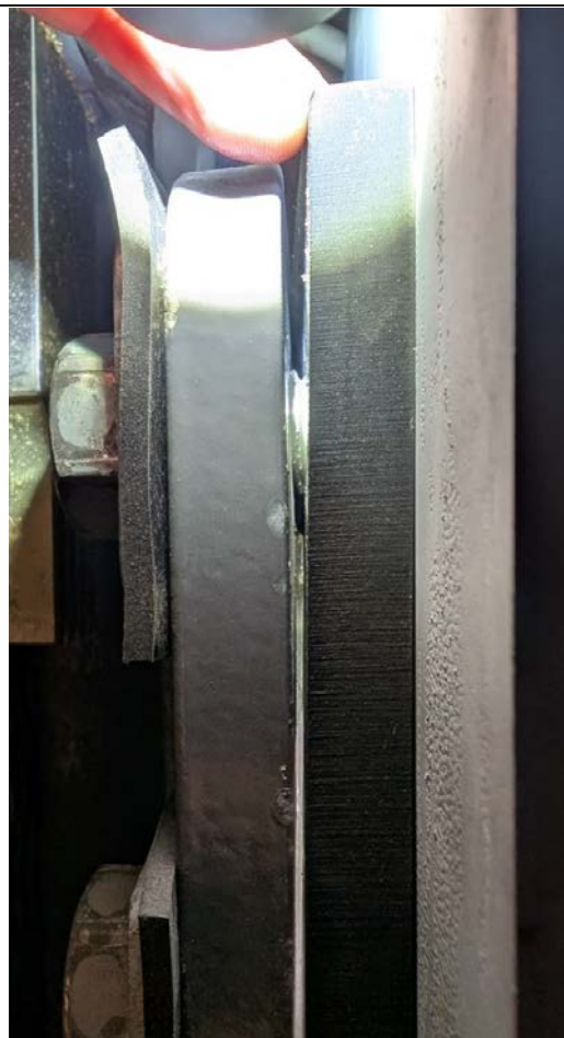
Foto 21: Klaring mellom braketter søyle, BK2
