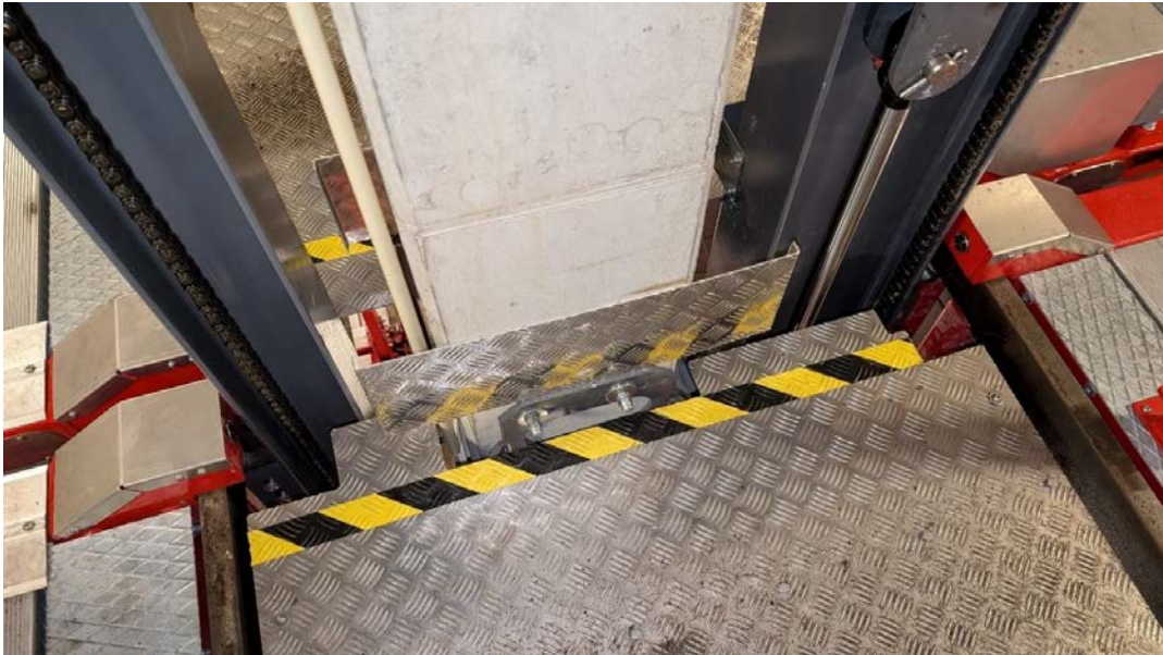
Foto 23: Kjøreplattform øvre nivå mellom rad A og B boltet til søyle
