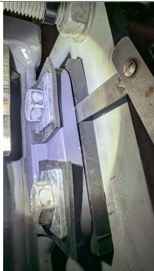
Foto 20: Klaring mellom braketter søyle, BK2
