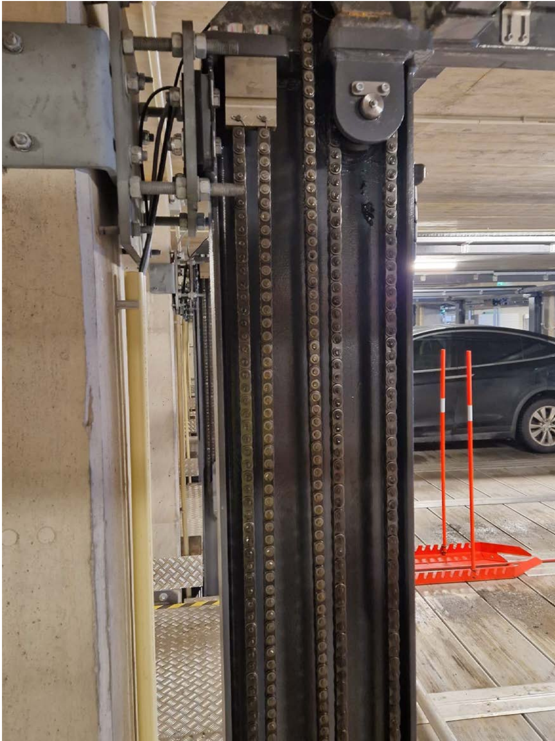
Foto 66: Innfesting mot søyle
