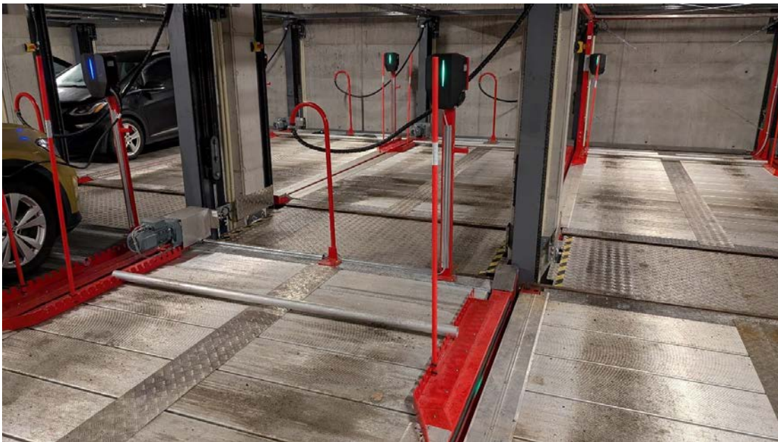
Foto 32: Kjøreplattform øvre nivå, BK2
