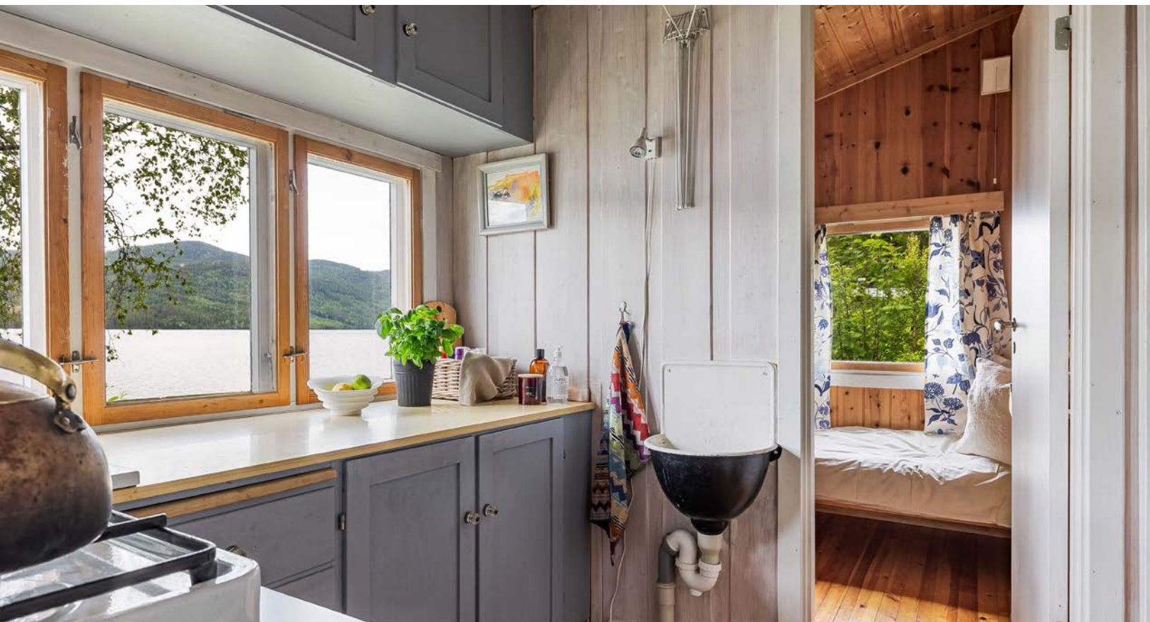
Sjarmerende eldre kjøkkeninnredning med profilerte fronter og laminert benkeplate. Det er montert en liten håndvask på vegg med gråvann ut i terreng.
