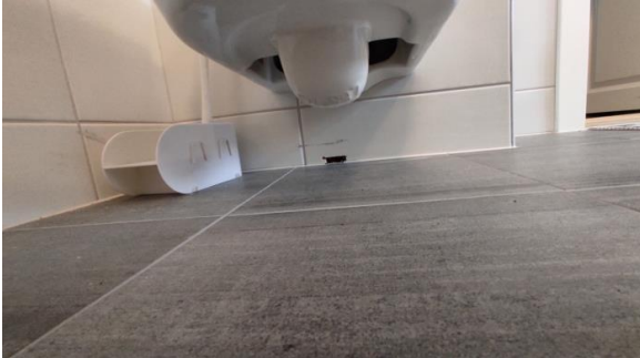
Drensåpning fra innebygd siserne.
