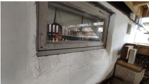
Vindu av eldre dato i kjelleretasje.
