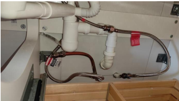
Kontroll av røropplegget.
