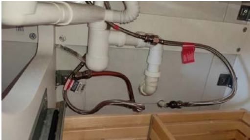
Kontroll av røropplegget.
