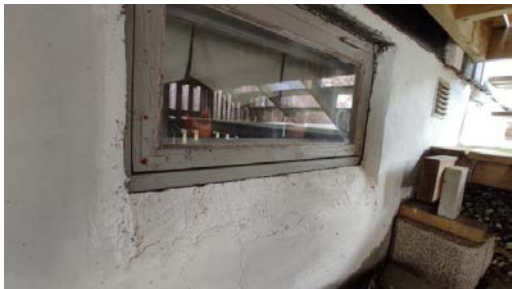
Vindu av eldre dato i kjelleretasje.
