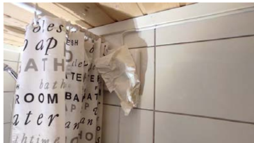
Funksjonstest av avtrekk.
