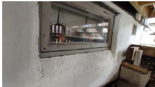
Vindu av eldre dato i kjelleretasje.
