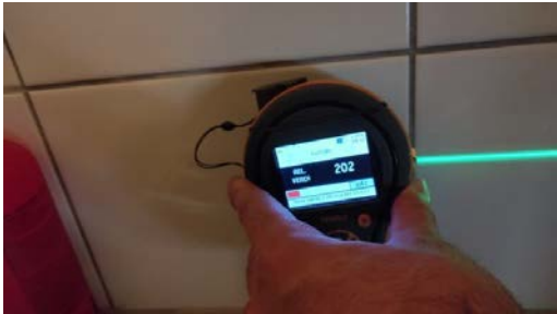
Fuktsøk på vegg.
