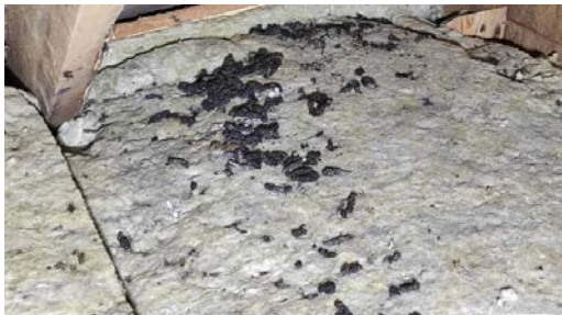
Utettgjennomføring av pipeløpet.
