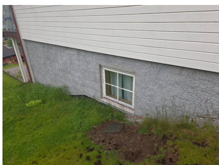
Grunnmursplast er pusset inn med kantlist
