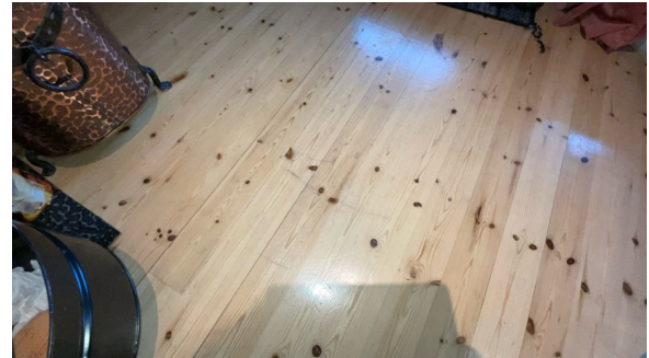
Litt slitasje på furugulv i kjeller
