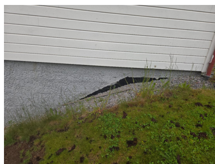
Grunnmursplast er pusset inn med kantlist
