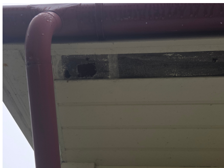
Skade/hull på insektsduk i raftekaske/takutstikk
