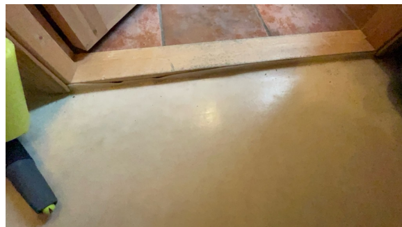
Anbefaler å montere vinkel list mot dørterskel for å sikre belegget
