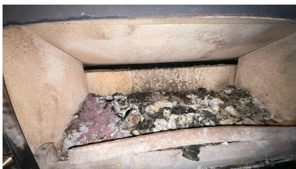
Sprekker i stein underetasje
