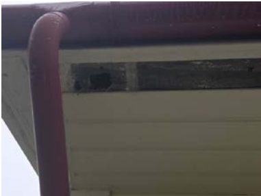
Skade/hull på insektsduk i raftekasse/takutstikk
