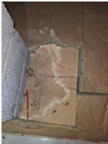
Skade/hull på insektsduk i raftekasse/takutstikk
