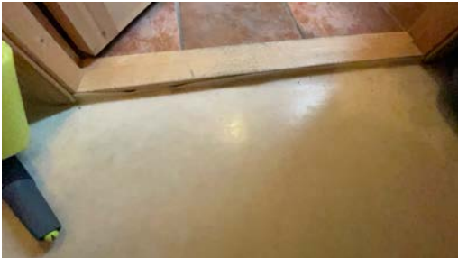
Anbefaler å montere vinkel list mot dørterskel for å sikre belegg
