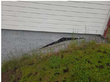
Grunnmursplast er pusset inn med kantlist
