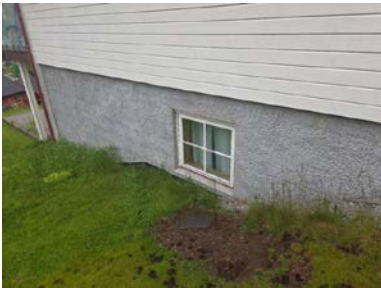
Grunnmursplast er pusset inn med kantlist
