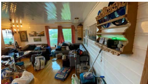
1. etasje. Plassering av laser ved kontroll av stue. Det er målt 10 mm høydeforskjell gjennom rommet. TG 1
