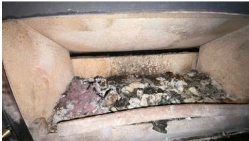
Sprekker i stein underetasje
