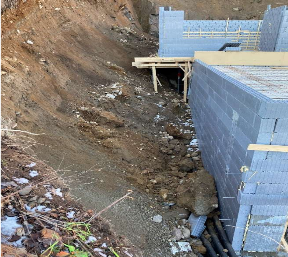
Nedraсте masser fra skråning mot Vest- mot drensledning uten grunnmursplast og membran
