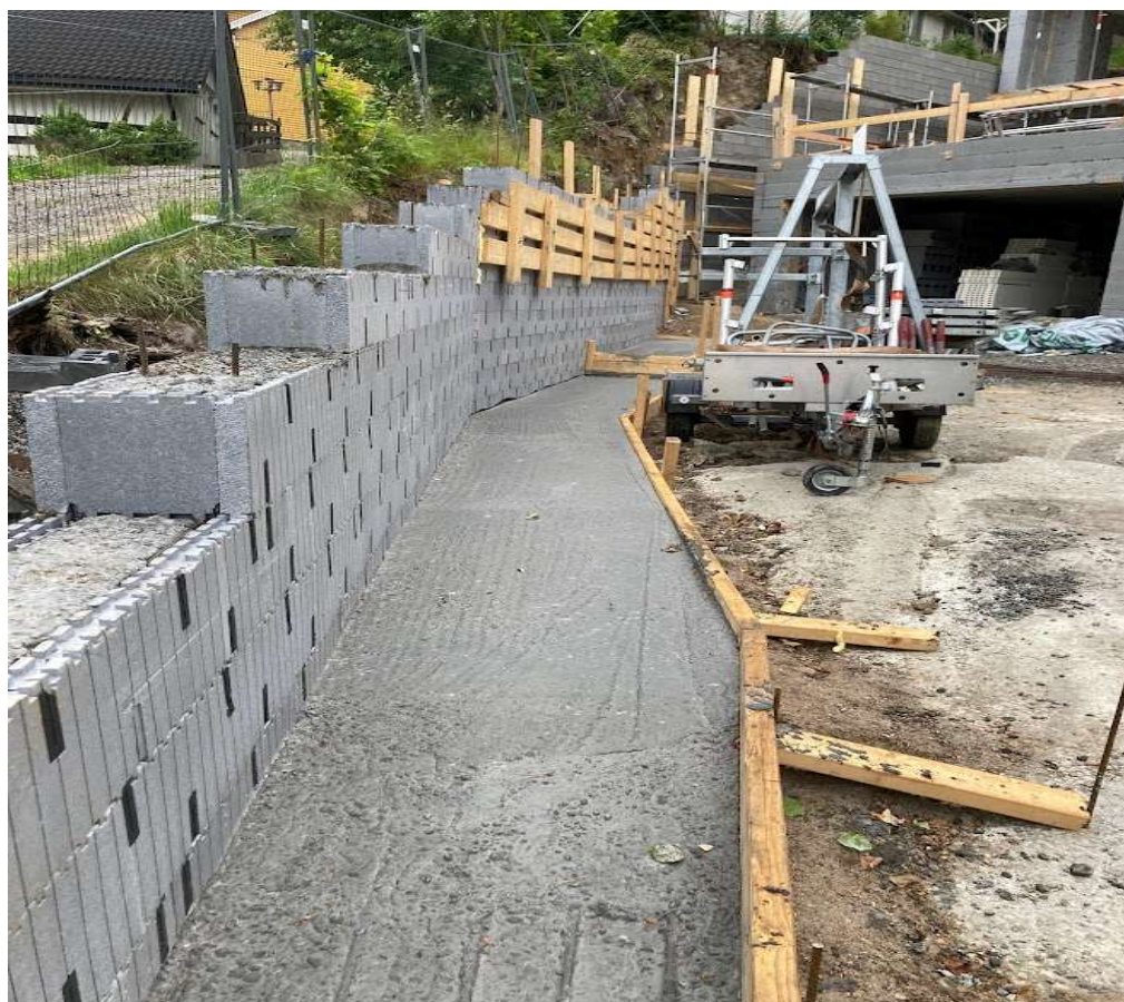
Skråning mot Vest
