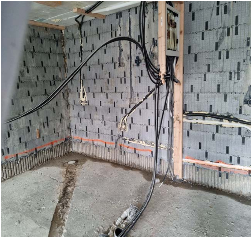
Innv. fukt fra bakvegg
