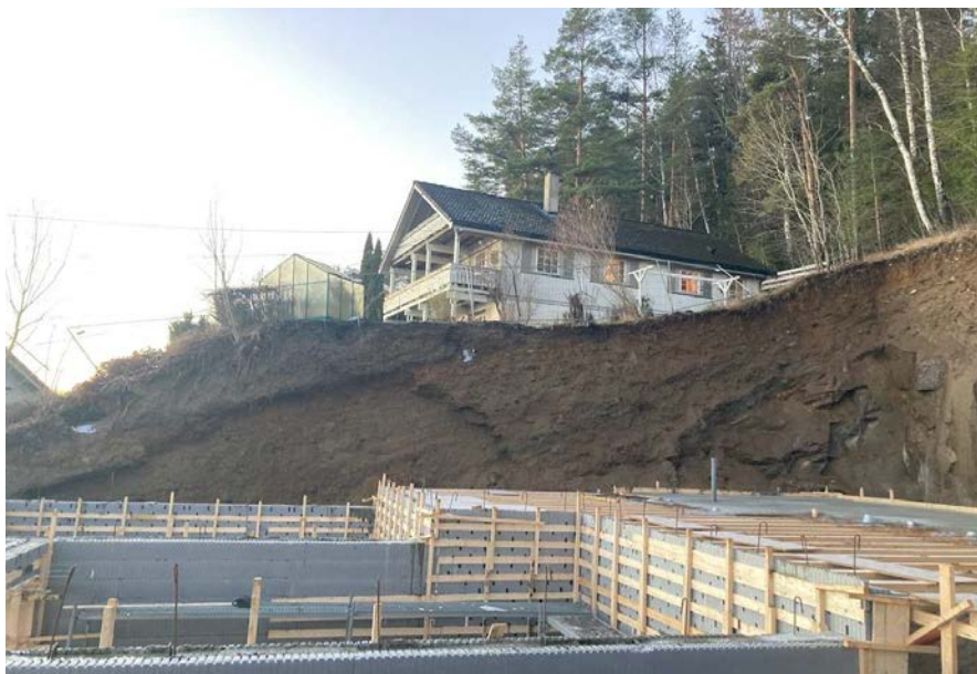
Høy usikret skråning mot Vest
