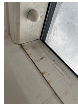
Skade vindu innglasset balkong
