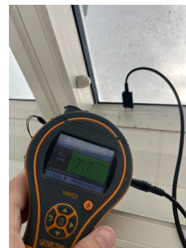
Fuktmåling vindu innglasset balkong
