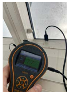
Fuktmåling vindu innglasset balkong
