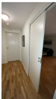
Skyvedør mellom stue/kjøkken og gang
