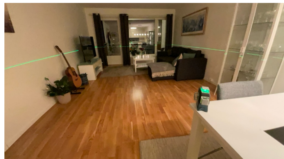
1. etasje. Plassering av laser ved kontroll av stue. Det er målt 10 mm høydeforskjell gjennom rommet. TG 1
