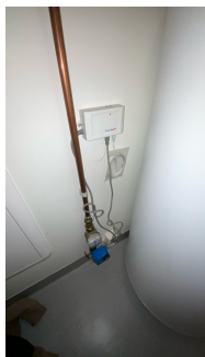
Hovedstoppekrane med vannstoppventil og vannmåler
